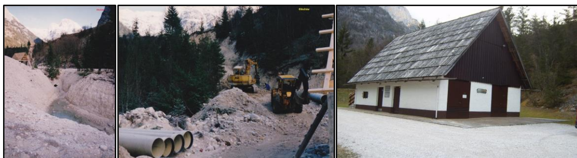
Slika 14: Gradnja MHE Krajcarca 41
